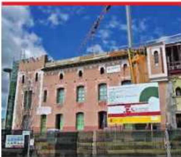
Imatge de les obres de rehabilitació i millora de l'escola Xamfrà-Sant Miquel que es varen portar a terme durant el 2010.
