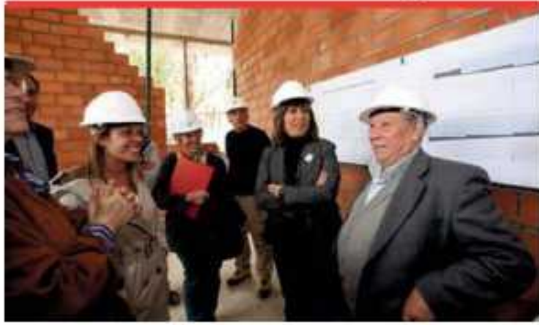
L'alcaldeessa Núria Marín durant la visita a les obres del Centre cívic.
