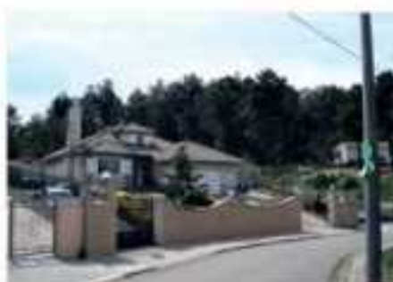
Lote 56 Vivienda Unifamiliar en Vidreres
