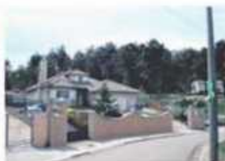
Lote 56 Vivienda Unifamiliar en Vidreres
