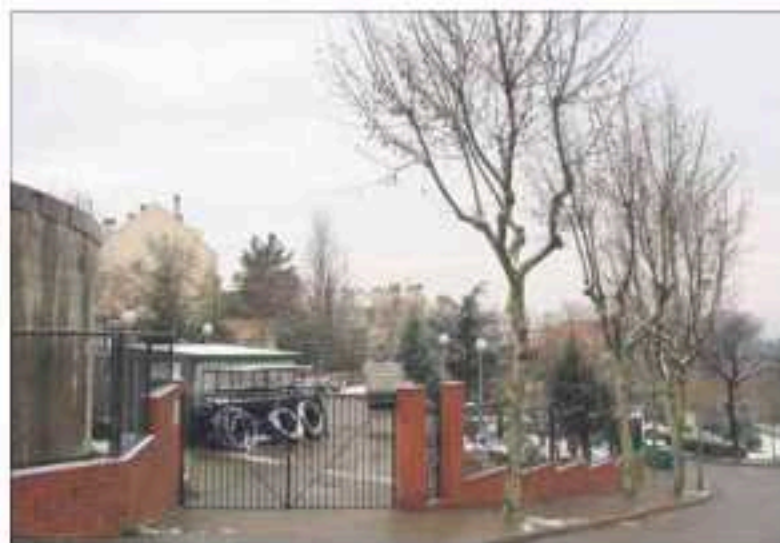
Dipòsit d'aigua municipal de la Font dels Casats. Molins de Rei.
