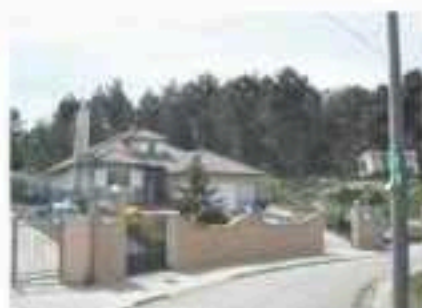
Lote 56 Vivienda Unifamiliar en Vidreres
