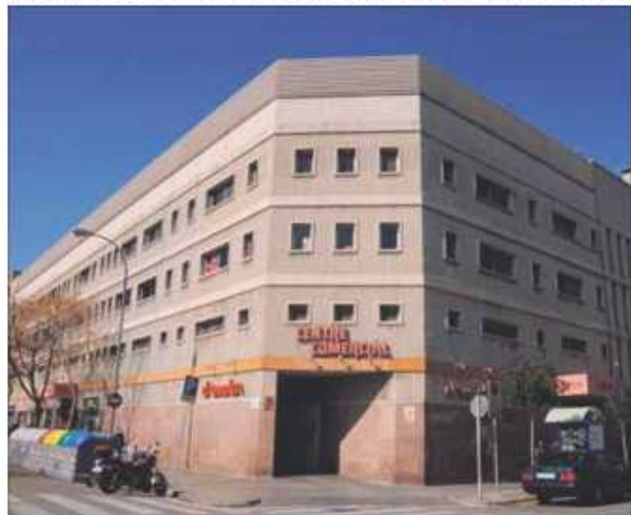
Edifici pendent de reforma en la coberta i neteja de la façana de l'edifici.
