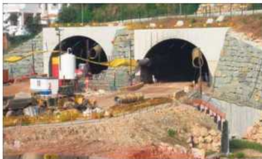
Obras de la variante de la N-340
