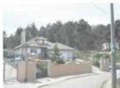
Lote 56 Vivienda Unifamiliar en Vidreres
