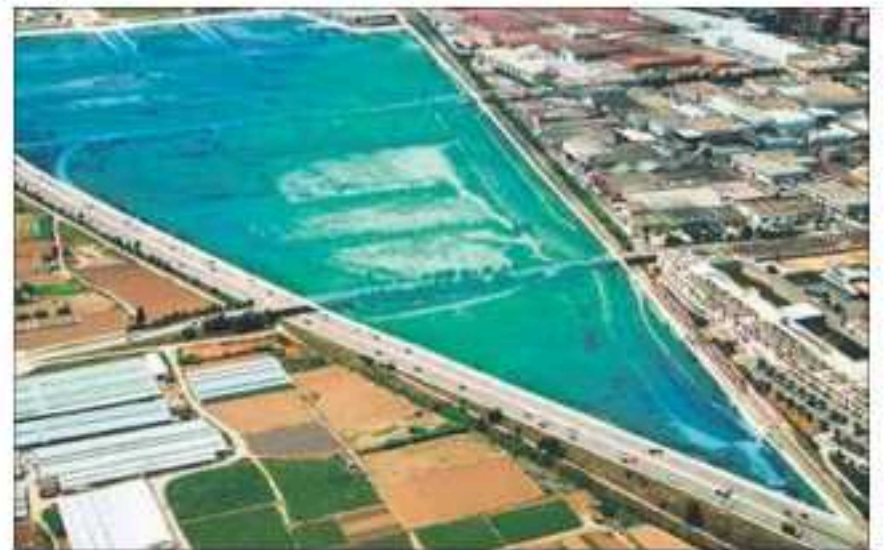
Ubicación del 'outlet' en la zona de Can'Alemany de Viladecans.
