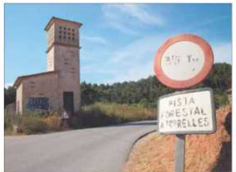
La pista ya está parcialmente asfaltada.
