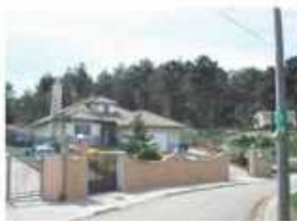
Lote 56 Vivienda Unifamiliar en Vidreres
