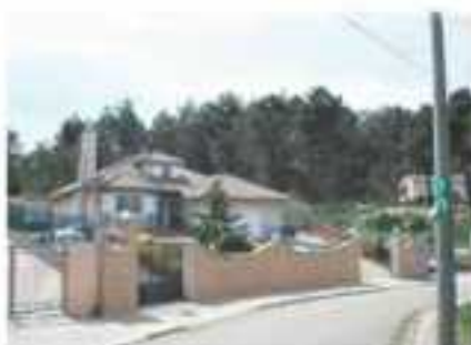
Lote 56 Vivienda Unifamiliar en Vidreres
