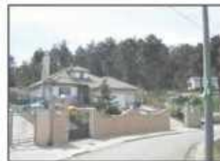
Lote 56 Vivienda Unifamiliar en Vidreres
