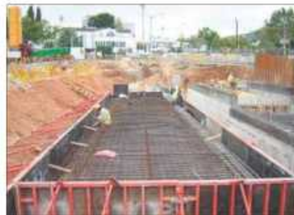
Obres de construcció de les estacions de Collblanc, Torrassa i Gornal de la Línia 9 del Metro.
