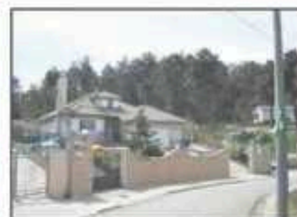
Lote 56 Vivienda Unifamiliar en Vidreres
