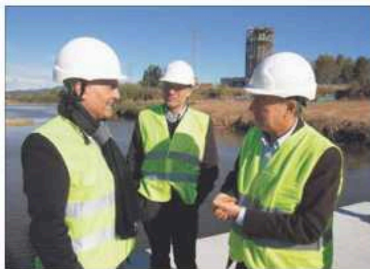
Visita d'obres de l'alcalde de Sant Joan Despí, Antoni Poveda, i l'alcalde de Sant Boi, Jaume Bosch, a la passera sobre el riu Llobregat que s'ha construït en els termes municipals de tots dos municipis.
