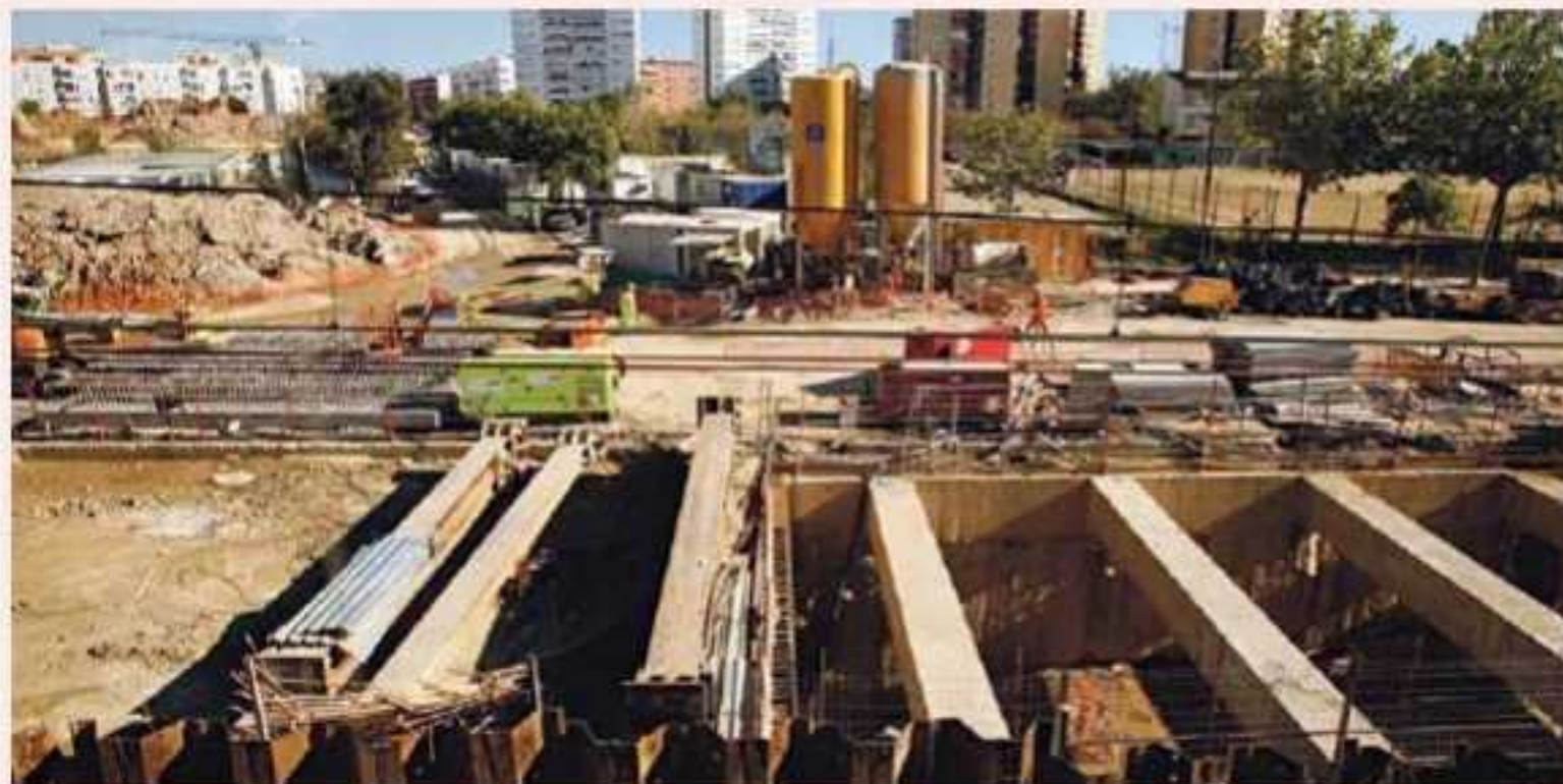
Obras del AVE a su paso por Bellvitge, en L'Hospitalet de Llobregat, donde se produjeron la mayoría de socavones
