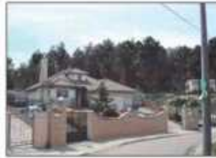
Lote 56 Vivienda unifamiliar en vidreres
