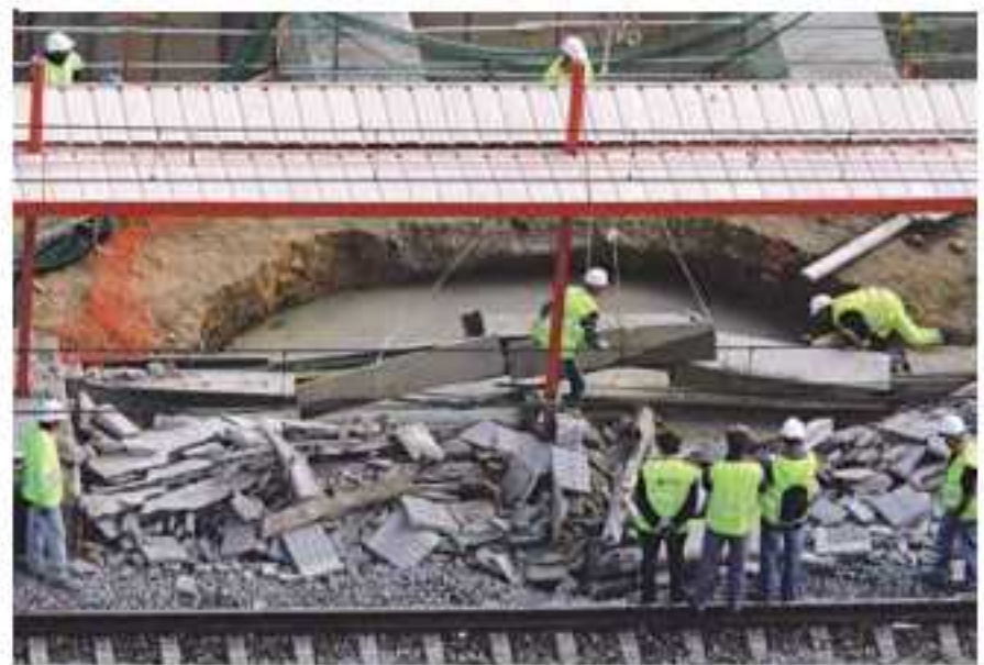
Operarios de Adif trabajando alrededor de uno de los socavones
