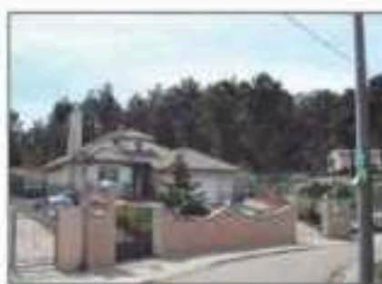
Lote 56 Vivienda unifamiliar en vidreres
