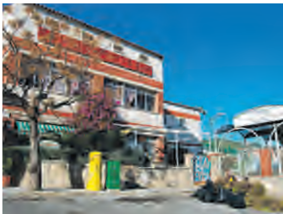
EL CASINO ESTÁ EN UN EVIDENTE ESTADO DE ABANDONO
