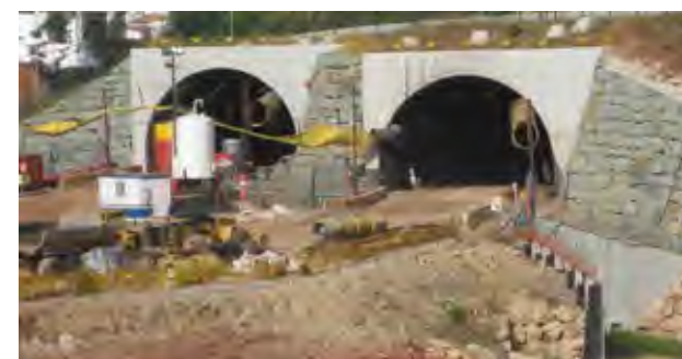
OBRES DE LA VARIANT DE VALLIRANA | ARXIU
