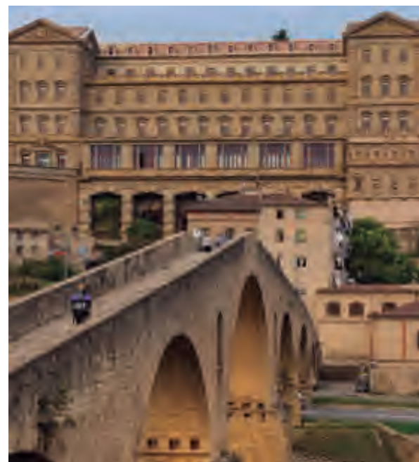
PONT VELL DE MANRESA
