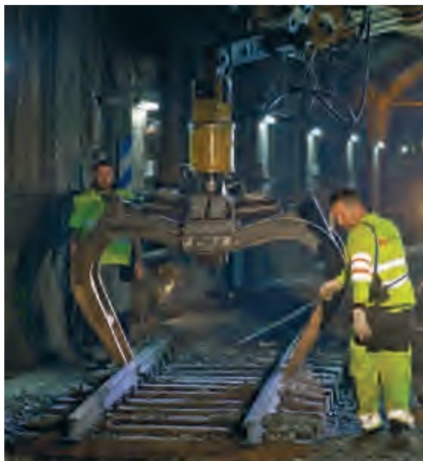
S'ESTAN RENOVANT ALGUNS TRAMS DE VIA DE LA LÍNIA | FGC
