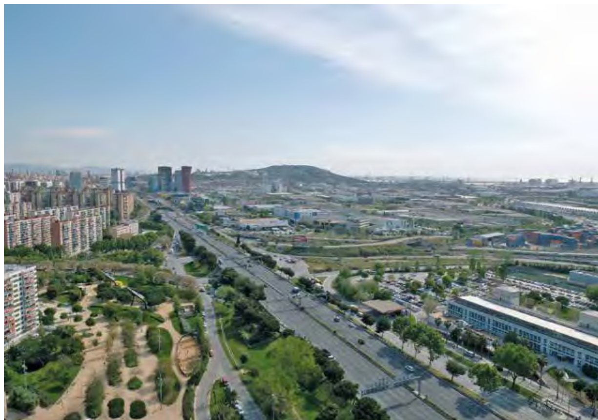
SI LA TERCERA FASE DE LAS OBRAS COINCIDE CON EL SOTERRAMIENTO DE LAS VÍAS DE RENFE PODRÍA CUBRIRSE LA GRAN VÍA ENTRE EL GORNAL Y BELLVITGE
