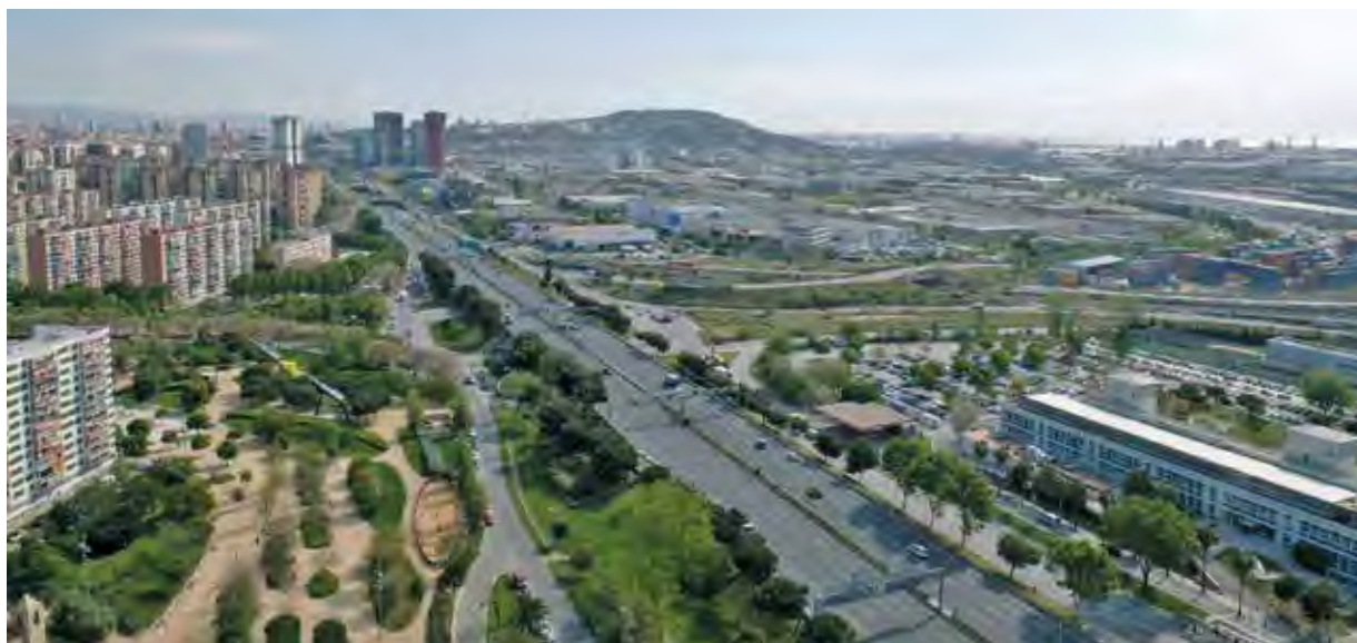
VISTA AÉREA DEL SECTOR DE LA GRANVIA DE L'HOSPITALET AFECTADO POR LA NUEVA COBERTURA, CON LA PLAZA EUROPA AL FONDO
