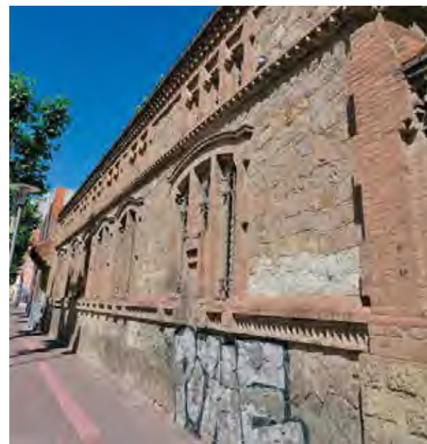
ANTIGUA FÁBRICA DE CAN TRINXET EN L'HOSPITALET
