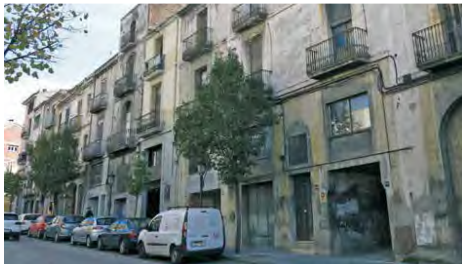
CALLE DEL MUR DE MARTORELL, QUE SIGUE A MOGUER COMO LA CIUDAD CON LA VIVIENDA MÁS DISPARADA
