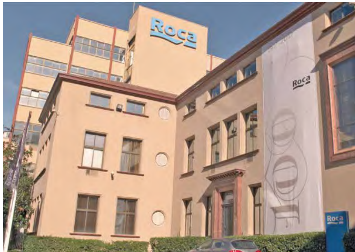
EN LAS INSTALACIONES DEL HUB DE LA CONSTRUCCIÓN DE GAVÀ Y VILADECANS SE EMPLAZARÁ LA SEDE MUNDIAL DE ROCA GROUP
