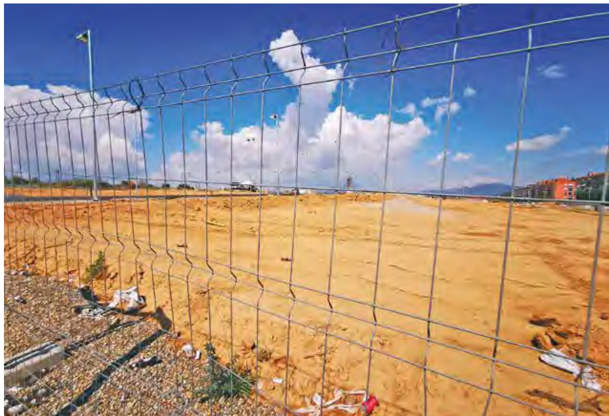
YA HAN EMPEZADO LAS OBRAS DE LA PROMOCIÓN PARC DE LA SÍNIA LIDERADA POR URBANIA EN ESTE SOLAR DEL NUEVO ENSANCHE DE MARTORELL (FOTO: BCN CONTENT FACTORY)
