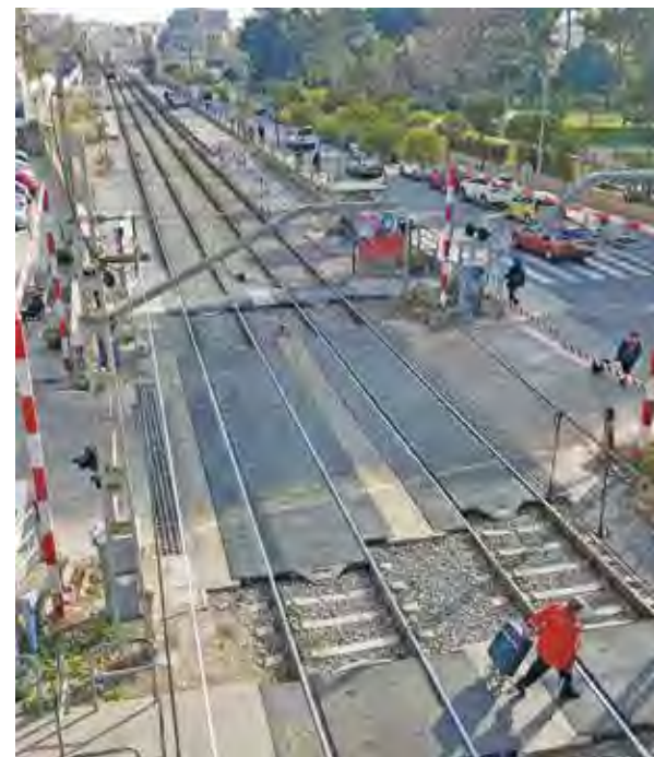
CON LA ELIMINACIÓN DE LAS VÍAS TAMBIÉN FINALIZARÁ LA INSEGURIDAD DE LOS PASOS A NIVEL
