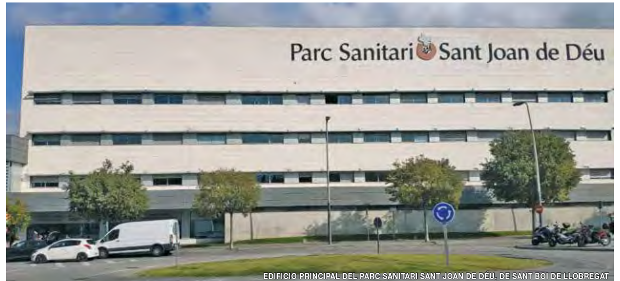
EDIFICIO PRINCIPAL DEL PARC SANITARI SANT JOAN DE DÉU, DE SANT BOI DE LLOBREGAT
