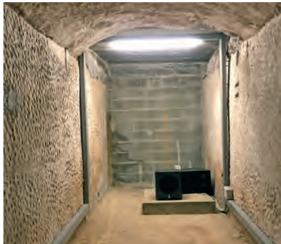
LA GALERÍA TIENE 124 METROS DE LONGITUD, DOS METROS DE ANCHURA Y DOS DE ALTURA; CON MUROS PERIMETRALES DE 40 CENTÍMETROS DE GROSOR
