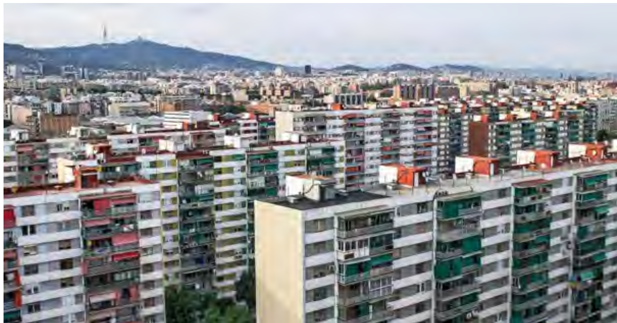
LA PRIORITAT ÉS ACONSEGUIR UNA MAJOR EFICIÈNCIA ENERGÈTICA I LA INTEGRACIÓ ALS EDIFICIS DE FONTS D'ENERGIA RENOVABLE QUE SUPOSIN UNA MILLORA DE LA CONSERVACIÓ
