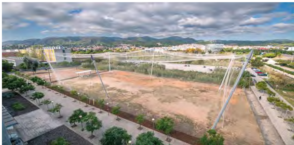
EL DRONELAB DISPOSA D'UN RECINTE DE VOL DE DRONS SEGREGAT DE L'ESPAI AERI GENERAL I LLIURE DELS REQUERIMENTS DE LA REGULACIÓ AÈRIA.
