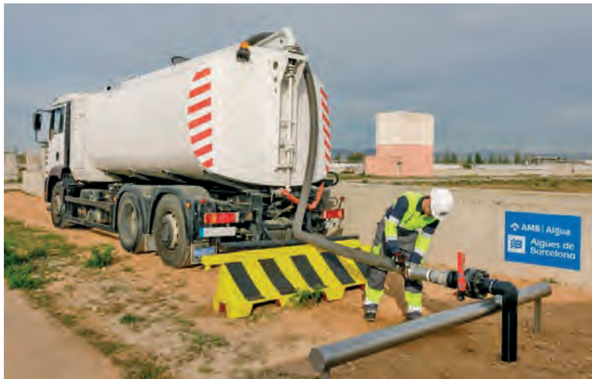
UN OPERARIO CONECTANDO EL CAMIÓN CUBA A LA FUENTE DE AGUA REGENERADA DE LA ECOFACTORÍA DE EL PRAT. (FOTO: AIGÜES DE BARCELONA)
