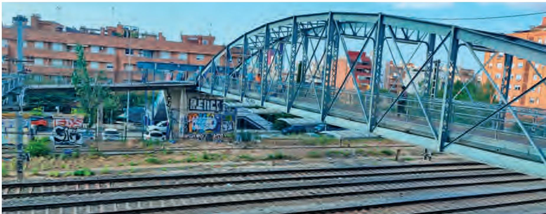
EL PONT D'EN JORDÀ ÉS UN DELS ELEMENTS MÉS IMPORTANTS I SINGULARS D'OBRA PÚBLICA A L'HOSPITALET I, PER AQUEST MOTIU, ÉS PREVIST QUE NO QUEDI AFECTAT PEL PROJECTE DE SOTERRAMENT DE LES VIES FÈRRIES
