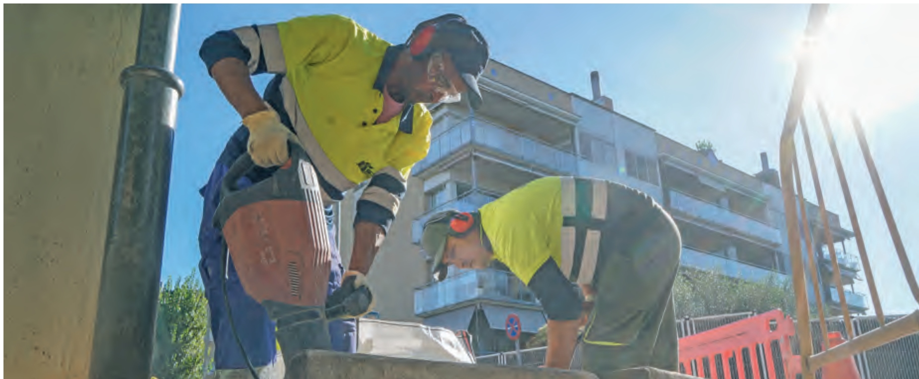
LOS TRABAJOS EN LA VÍA PÚBLICA QUE CONFORMAN EL AMBICIOSO PROYECTO 4X100 DE ESPLUGUES, YA HAN COMENZADO A BUEN RITMO Y ESTÁ PREVISTO QUE FINALICEN EN VERANO DEL 2027 Y SE EJECUTEN EN CUATRO FASES
