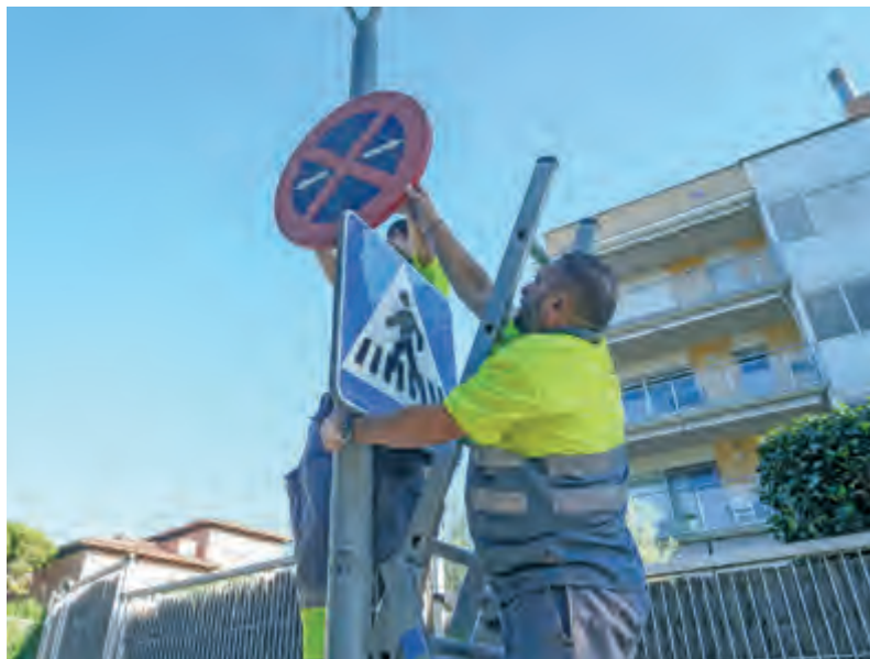
DOS OPERARIOS COLOCANDO SEÑALIZACIÓN ESPECIAL VIARIA POR EL COMIENZO DE LAS OBRAS
