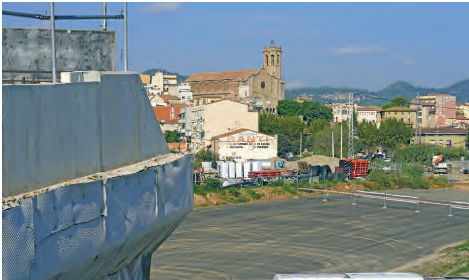
OBRAS DE CONSTRUCCIÓN DE LA FUTURA B-25, CON LA IGLESIA DE SANT BALDIRI Y EL CASC ANTIC DE SANT BOI, AL FONDO. TODO EL SECTOR QUE APARECE EN LA FOTOGRAFÍA SERÁ OBJETO DE UNA PROFUNDA RENOVACIÓN URBANÍSTICA
