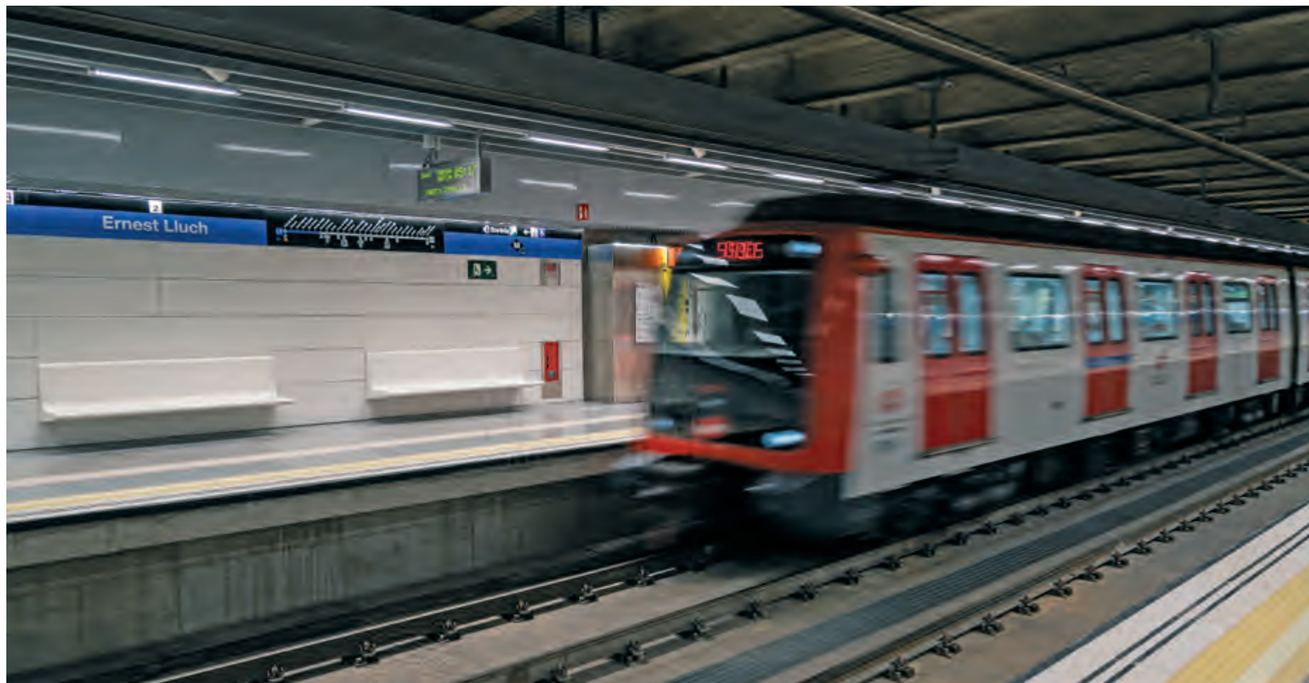
EN LA FOTO: ESTACIÓN DE ERNEST LLUCH (L5). PESE A LA IMPORTANTE CRISIS ECONÓMICA DE LOS ÚLTIMOS AÑOS, LA RED DE METRO NO HA DEJADO DE CRECER, EN CONCRETO HACIA L'HOSPITALET Y EL PRAT CON LAS LÍNEAS L9 Y L10 SUD
