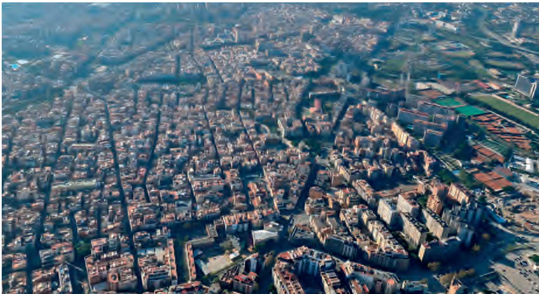
VISTA ÁREA DEL SAMONTÀ CON LOS BARRIOS DE COLLBLANC Y LA TORRASSA EN LA PARTE INFERIOR Y PUBILLA CASES, LA FLORIDA Y LES PLANES EN LA PARTE SUPERIOR. EL VIAL LONGITUDINAL MÁS ANCHO ES LA CARRETERA DE COLLBLANC
