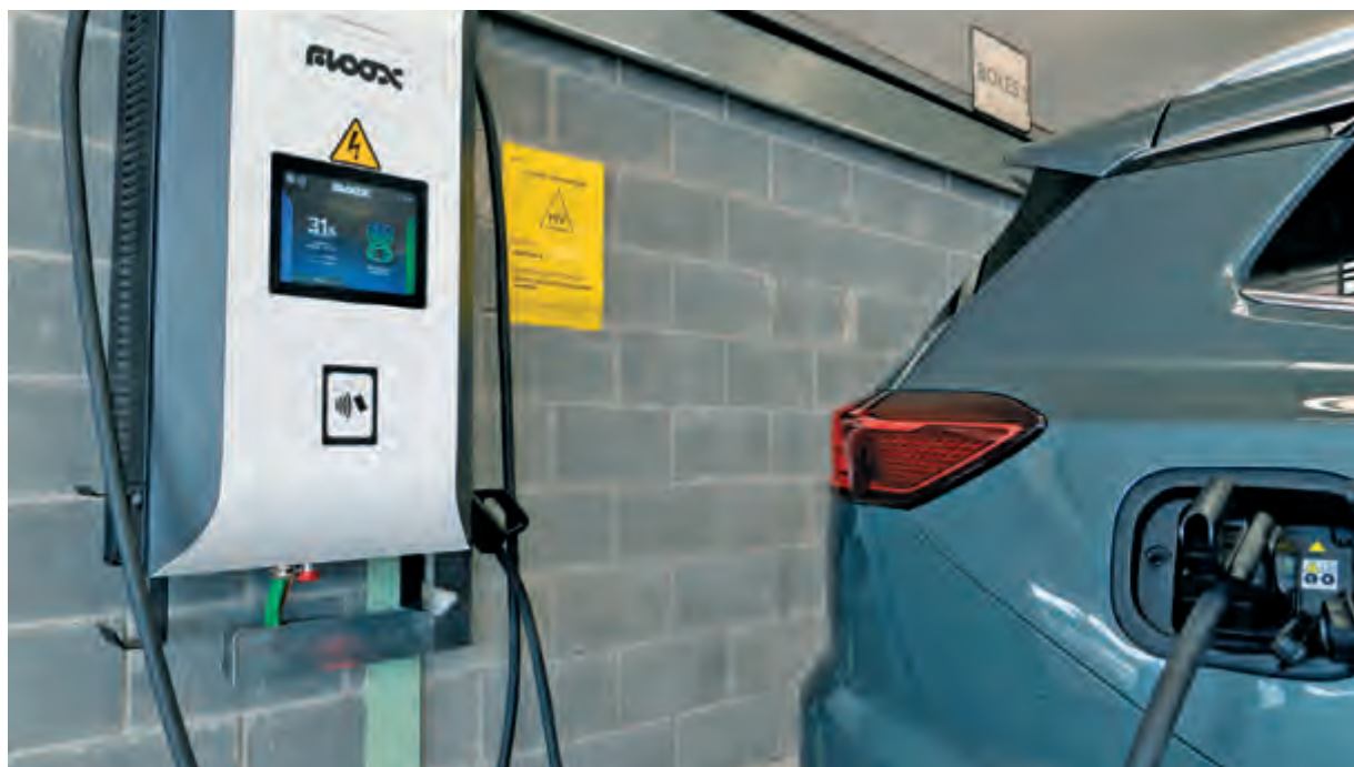
EL LYRA 80 ES CAPAZ CARGAR MÁS DEL 80% DE LAS BATERÍAS DE UN COCHE ELÉCTRICO O ENCHUFABLE EN MEDIA HORA O MÁS DEL 60% EN 20 MINUTOS
