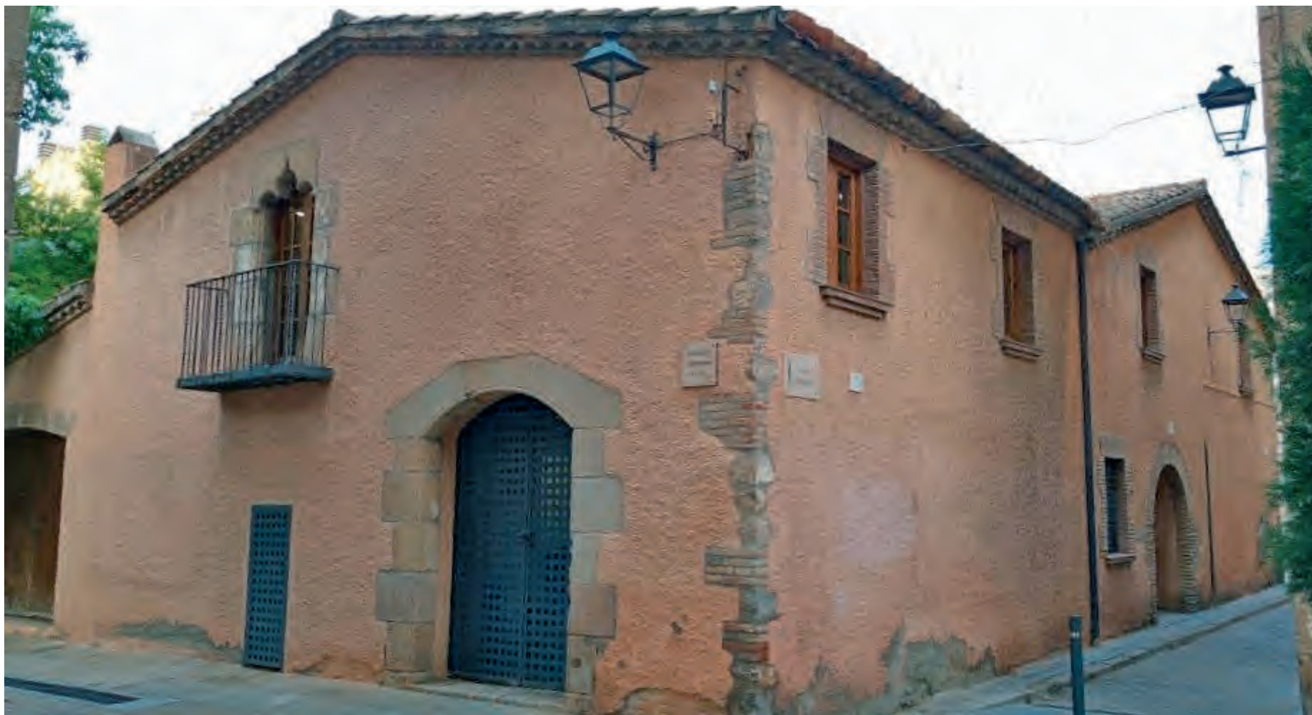
MASÍA DE CA N'OLIVER. LLAMA MUCHO LA ATENCIÓN QUE LAS MASÍAS ESTÁN A UN NIVEL MÁS BAJO QUE LOS EDIFICIOS CONTIGUOS PERO ES EL 'MAS' EL QUE ESTÁ AL NIVEL ORIGINAL, EL RESTO DE LA CIUDAD HA CAMBIADO DE POSICIÓN
