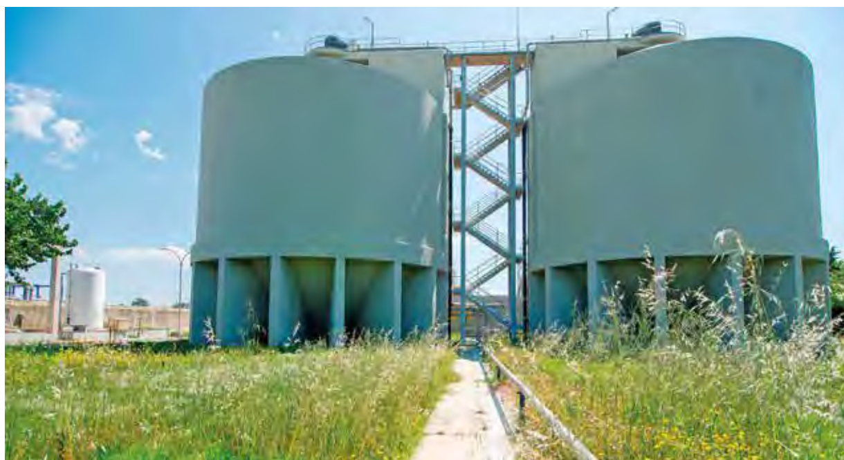
LA DEPURADORA DE GAVÀ-VILADECANS, EXEMPLE DE LA INTEGRACIÓ DE BIODIVERSITAT A LES INSTAL·LACIONS DEL CICLE DE L'AIGUA
