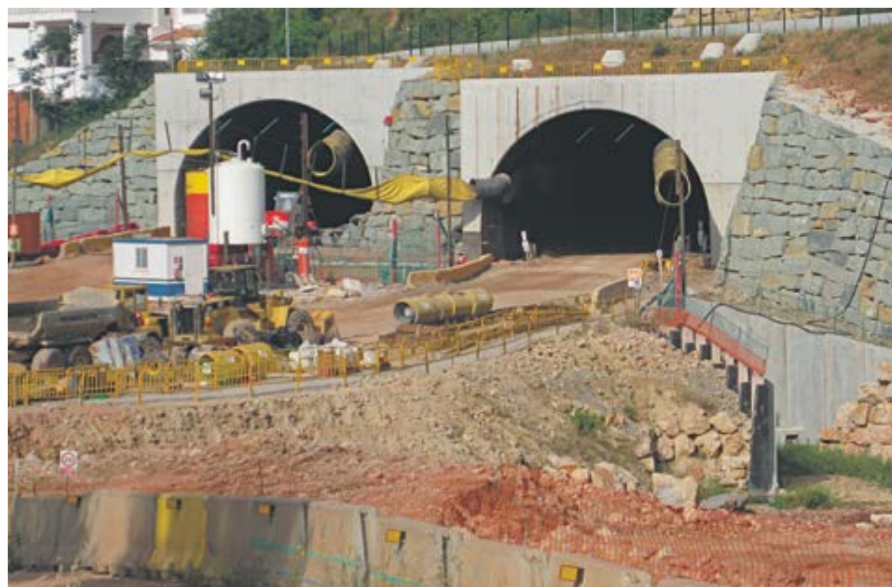
ESTAT DE LES OBRES AL NOVEMBRE DE 2014, JUST QUAN ES VAN REANUDAR DESPRÉS DE TRES ANYS ATURADES | ARXIU
