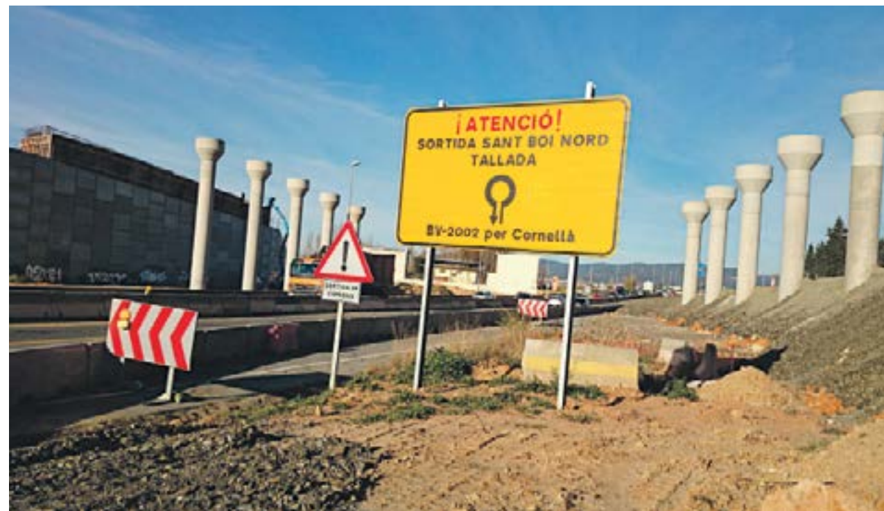
L'ALCALDESSA DE GAVÀ, RAQUEL SÁNCHEZ, A LA PRESENTACIÓ DE LES INVERSIONS PREVISTES A LA CIUTAT PEL QUE QUEDA DE MANDAT; I IMATGE DE LES OBRES ATURADES DE LA C-245, QUE AFECTA TAMBÉ A GAVÀ. LA CIUTAT APORTARÀ LA PART CORRESPONENT PER FER UN NOU CARRIL BUS I BICI, A MÉS DE FER UN PAS DE VIANANTS PER ACCEDIR AL TANATORI.
