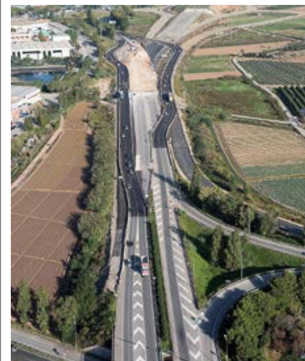
DESVIAMENTS PROVISIONALS PENDENTS DE L'OBRA | TERRITORI I SOSTENIBILITAT
