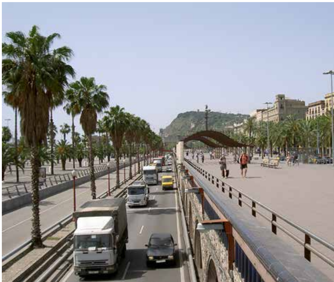
RONDA DE DALÍ I PASSEIG DE COLOM, INFRAESTRUCTURA URBANA DE BARCELONA
