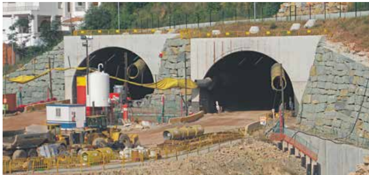
OBRES DE LA VARIANT N-340 AL SEU PAS PER VALLIRANA
