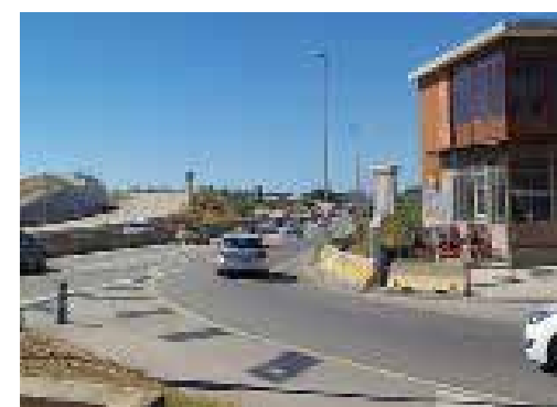
LAS OBRAS DE LA VARIANTE DE LA C-245 REABREN EL ACCESO SUR A SANT BOI ANTE LA PARÁLISIS DE LAS OBRAS
