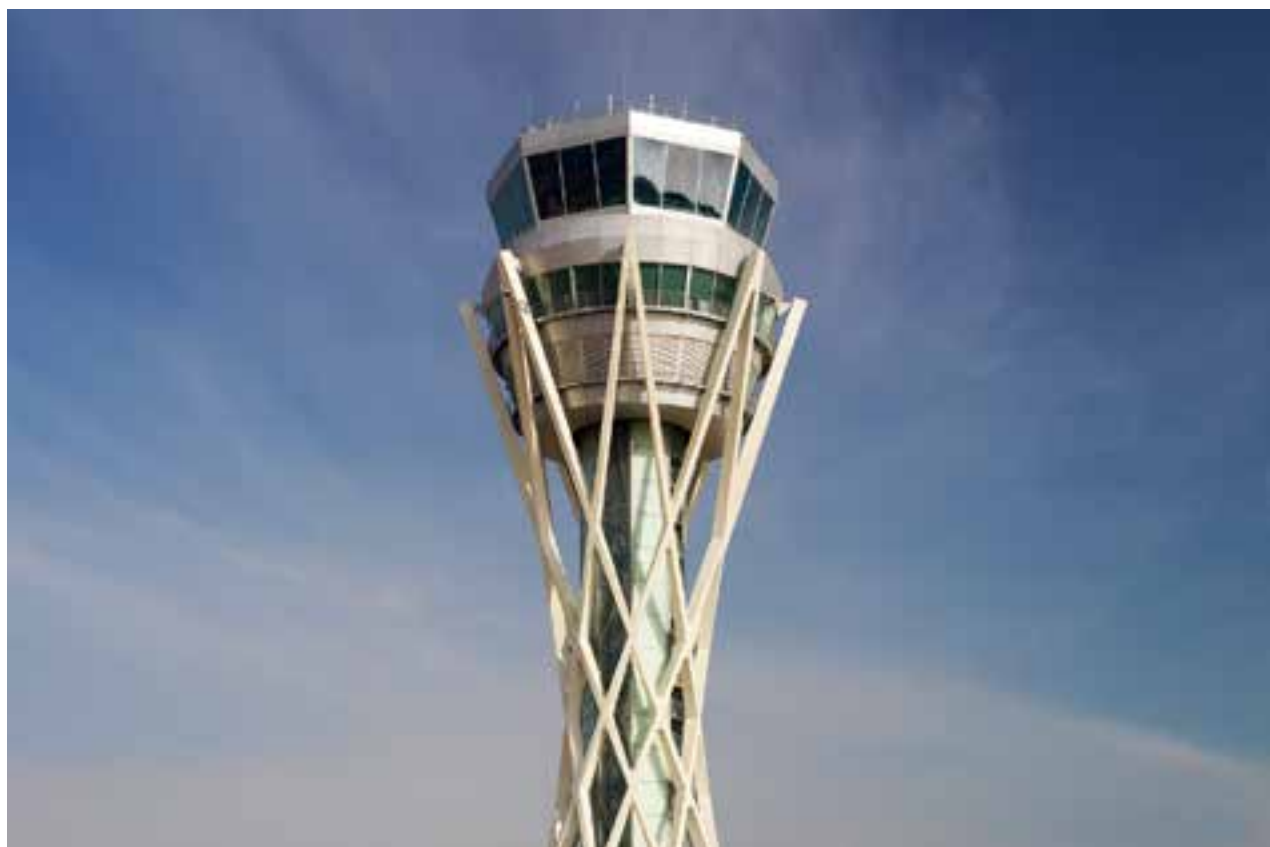
IMATGE DE LA TORRE DE CONTROL DE LA TERMINAL 2 DE L'AEROPORT DE BARCELONA
