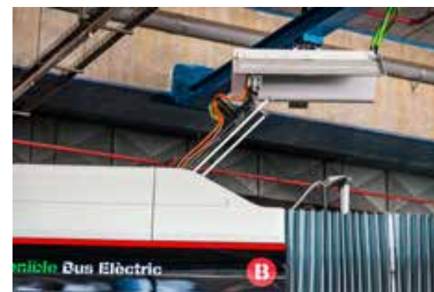
SISTEMA DE RECÀRREGA D'UN BUS ELÈCTRIC
