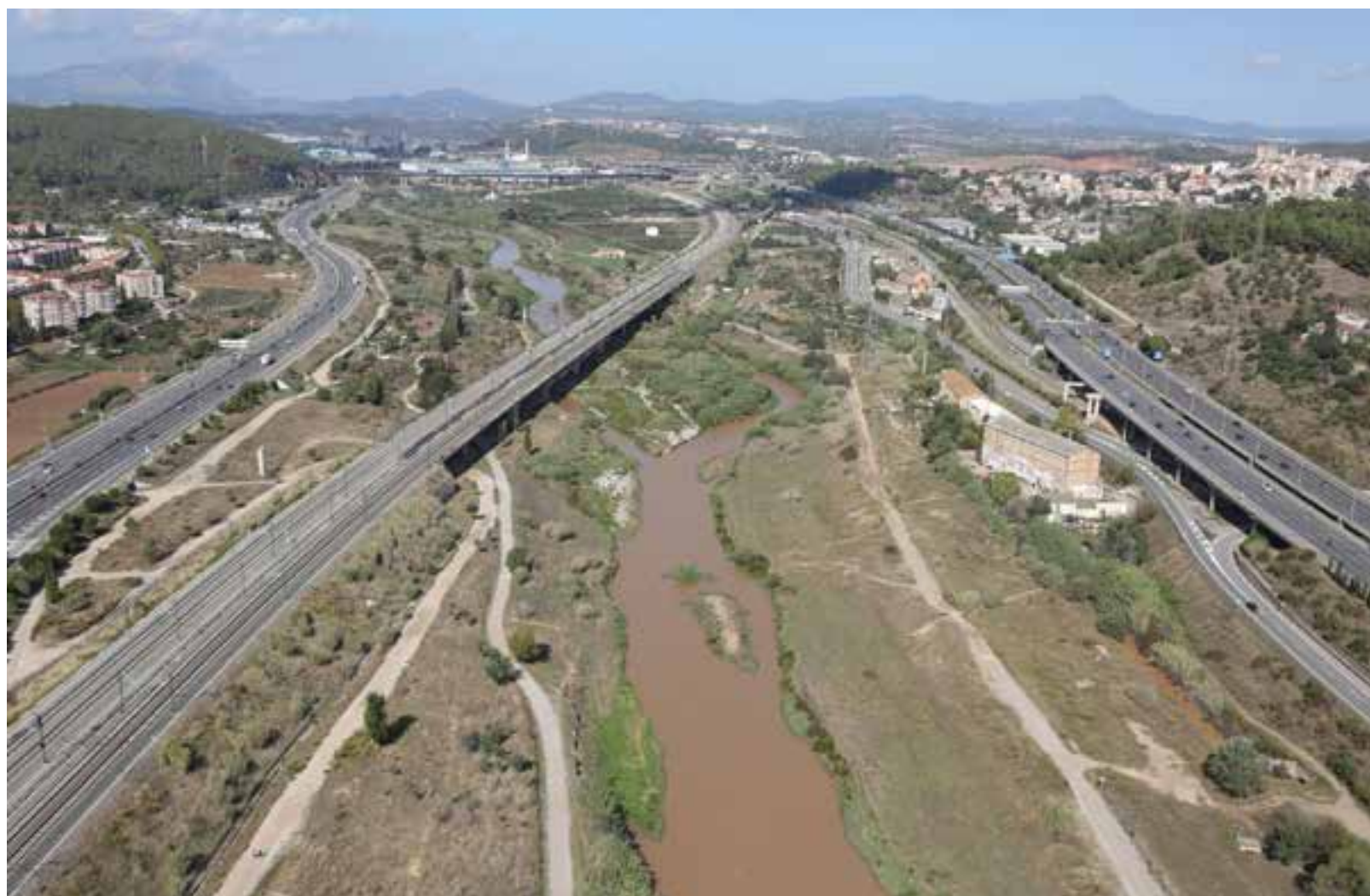
EL RIU LLOBREGAT I LES VIES AP7 I A2, CONFLUÈNCIA DE LA INFRAESTRUCTURA GRIS I L'ESPAI NATURAL
