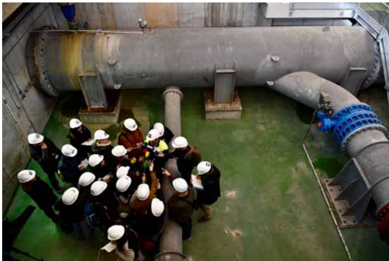
AQUESTA CANONADA PODRIA IMPULSAR AIGUA REGENERADA AL RIU LLOBREGAT, A L'ALÇADA DE MOLINS DE REI
