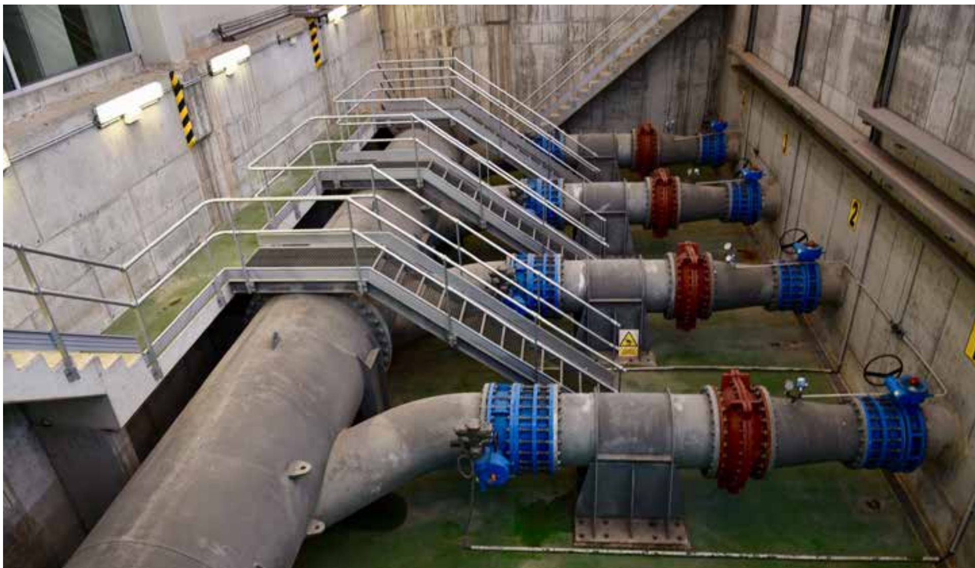
ASPECTE DE L'ESTACIÓ REGENERADORA D'AIGÜES DE LA DEPURADORA DEL BAIX LLOBREGAT, SITUADA AL PRAT
